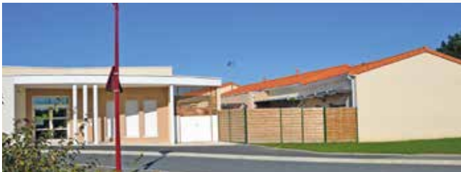
Saint Léger sous Cholet - La Ferronnière - 5 logements
