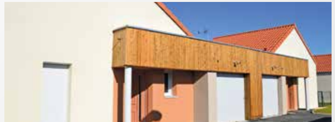
Saint Léger sous Cholet - Le Martineau II - 5 logements
